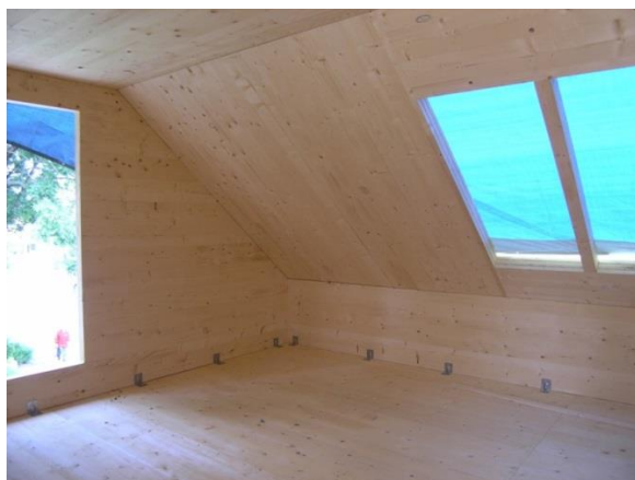
Obr. 10 Typický spoj CLT panelů
