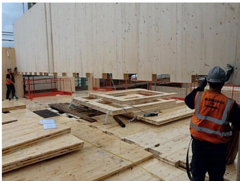
Obr. 12 Použití profilovaných CLT panelů
