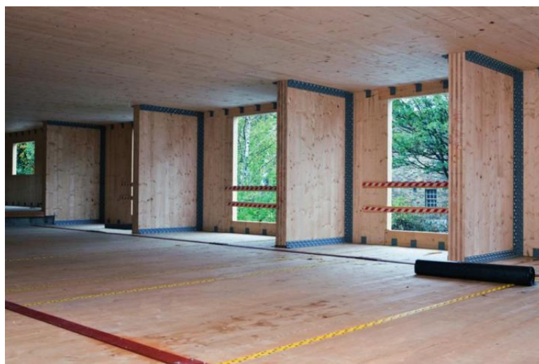
Obrázek 1 Připojení stěn po celé jejich délce
