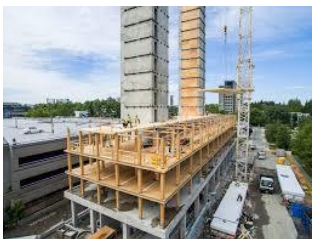
Obr. 21 Budova Brock-Commons ve Vancouveru
